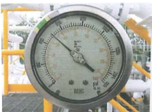
รูปมาตรวัดแรงดันหลังออกจากอุปกรณ์ปรับแรงดัน
