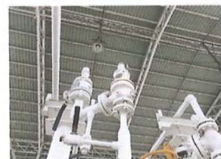
รูปอุปกรณ์ควบคุมความดันก๊าซเกินพิกัดแบบระบาย
